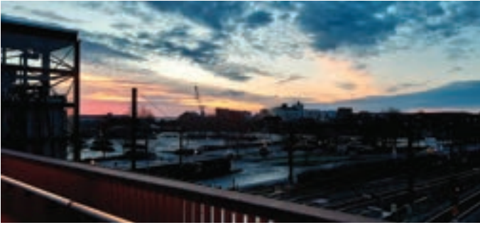
Stationsbroen Station Bridge Bahnhofsbrücke Stationspladsen, 4600 Køge
